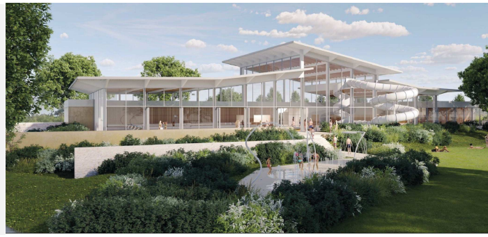
Vue depuis le solarium extérieur
